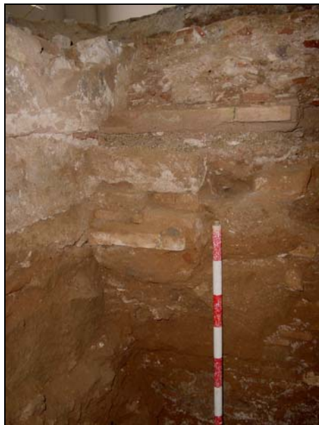
F19: Rasa 2, tram central, paviments UUEE 65, 220, 221 i arrebossats UUEE 120, 222, 223 del mur UE 119.
